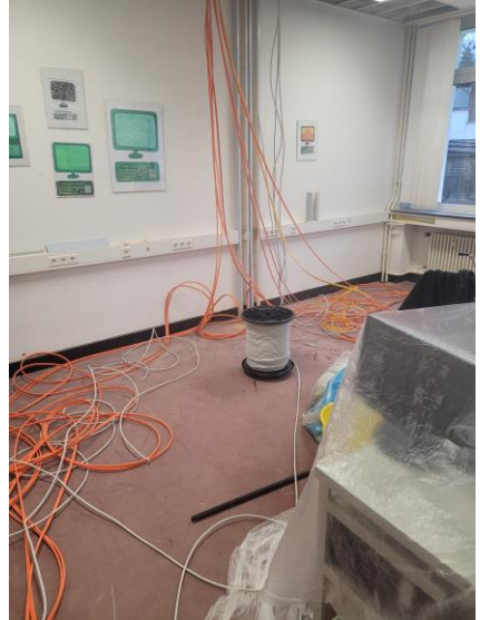
4 km Kabel wurden durch die Schule verlegt, damit wir im Schulgebäude Wlan bekommen.
