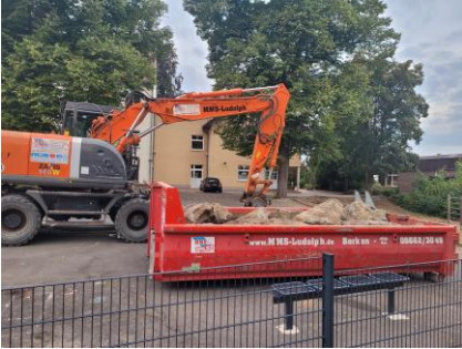
Der Bagger rückt an!
