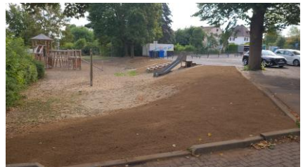
Begradigung der Hangfläche, die großen Steine kommen weg.
